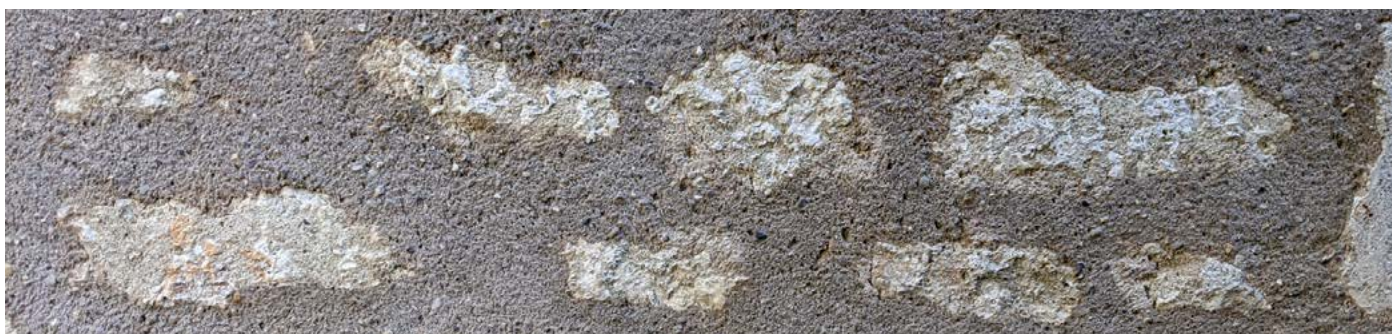
Mur de moellons en pierre vue
